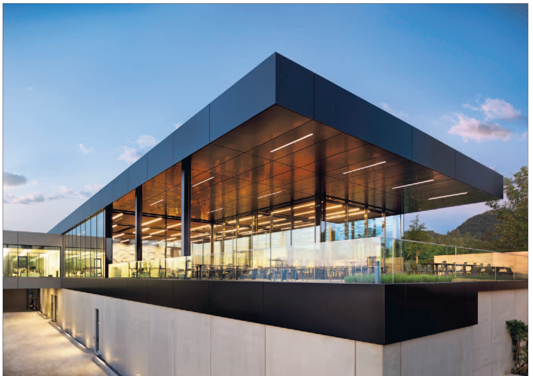
Der Reutlinger Weltmarktführer Institut Dr. Foerster ist in über 60 Ländern präsent. In Reutlingen entstand jetzt unter anderem dieses imposante Betriebsrestaurant.
